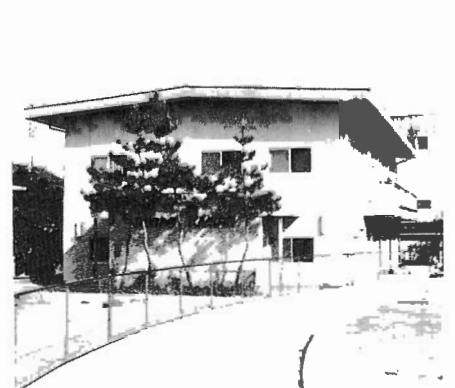
全面改築が予定される翠巒会館
