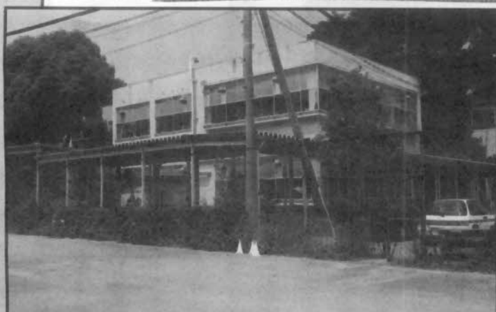
取り壊された旧理科棟
