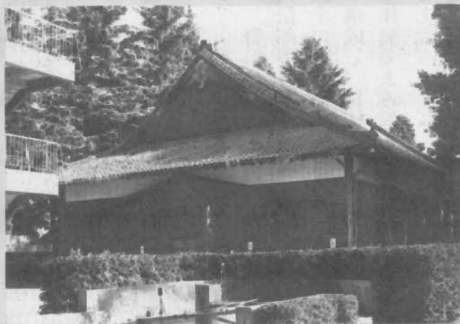
解体直前の講堂（H5年）
