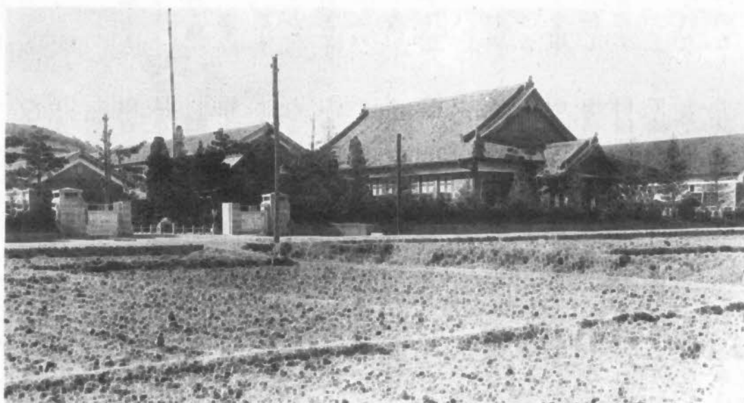
竣工なった講堂を望む
