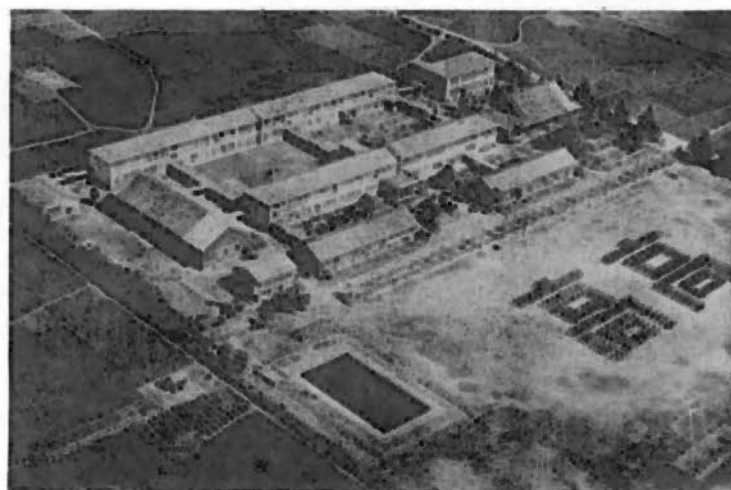
改築前の乗附校舎全景と玄関
