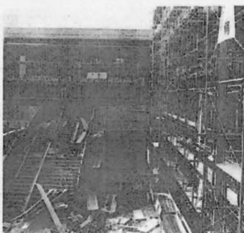
二期工事中新校舎 (写真は49回卒岩山写真提供)
